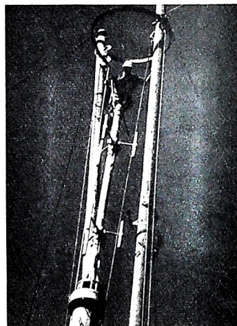
Bild 2 (links) und Bild 3 (oben). Die Bilder zeigen den schwierigsten Teil der Montagearbeiten: das Aufsetzen der etwa 20 m langen letzten Stufe (Bereich-II-Antenne mit aufgesetzter öbL-Antenne) auf das bereits bestehende rund 30 m hohe Turmstück. Dazu wurde der schon stehende Teil des Sendeturms mit zwei Holzmasten verlängert. An einem der Masten wurde eine Rolle angebracht, über die dann eine Motorwinde die oberste Stufe hinaufziehen konnte Aufnahmen: Mando Annoni, Luzern
